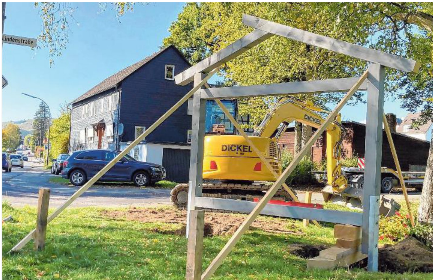
Das Gerüst steht: Sobald der Beton fest geworden ist, soll das Schild am Ortseingang von Berghausen mit der neuen Holztafel versehen werden. Foto: Lars Lennep
